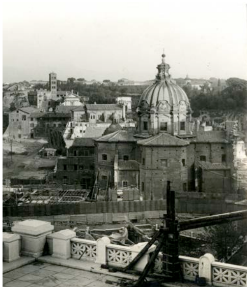
Fig. 10. Roma, lavori di demolizione per la realizzazione di Via dell'Impero, 1931, AASL, Miscellanea Fotografie.
