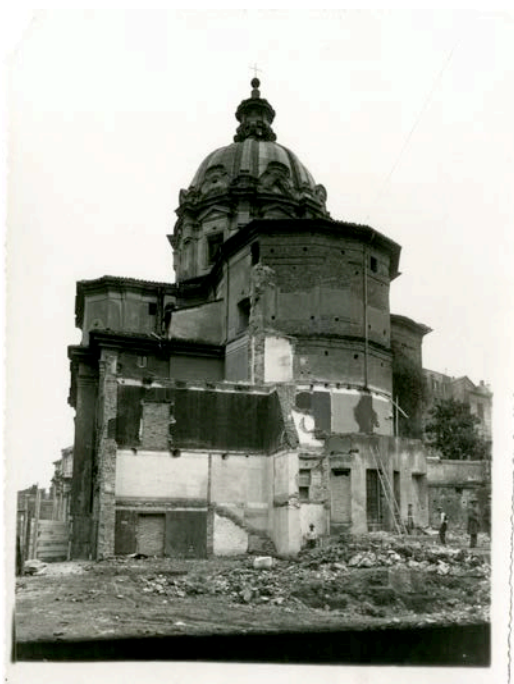
Fig. 9a. Lavori di demolizione e ricostruzione della sede dell'Accademia di San Luca in Via Bonella, 1932, AASL, Miscellanea Fotografie.
