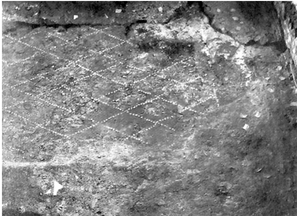
Fig. 8.7. Albano Laziale, villa in loc. Cavallacci, pavimento in cementizio decorato (da AGLIETTI, CUCCURULLO 2013a, fig. 2).
