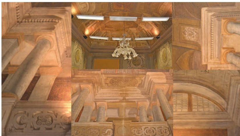
Fig. 6. Volta della Sala del Dentone, Palazzo Comunale di Bologna, Girolamo Curti con Francesco Castelli e Angelo Michele Colonna, 1627-1630 circa. Vista della sala con dettagli dell'ordine architettonico, del parapetto, della finestra termale e della trabeazione con dentelli.
