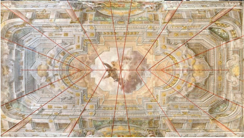
Fig. 3 Vista ortografica sulla volta dell'aula dedotta da nuvola di punti ed individuazione dei diversi punti di fuga che compongono la prospettiva architettonica.
