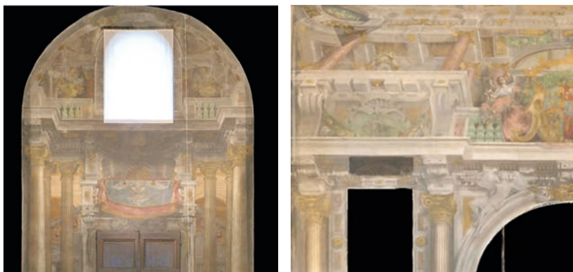
Figg. 7 a, b. Viste ortografiche dodotte da nuvole di punti. A sinistra, vista sulla controfacciata e a destra, sulla parete sinistra. Quest'ultima mostra, sovrapponendo in semitrasparenza la parte sinistra con la sua parte speculare, la perfetta corrispondenza delle parti replicate. La stessa corrispondenza rimane verificata anche tra pareti opposte.
