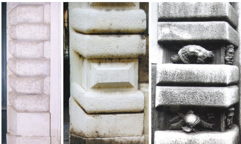
Fig. 27. Viste frontali di dettaglio di piedritti marmorei bugnati o a bugne alternate a specchiature. Si nota che la prospettiva è declinata nello sguincio, e che lo scorcio è verosimile grazie al ricorso a più punti di fuga.
