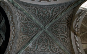
Fig. 18. Duomo di Biella, navata laterale, particolare dell'unità decorativa n. 4 (da Simionato 2010, estratto tav. 31).
