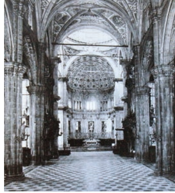
Fig. 13. Duomo di Como, navata centrale (da Gini 1972).
