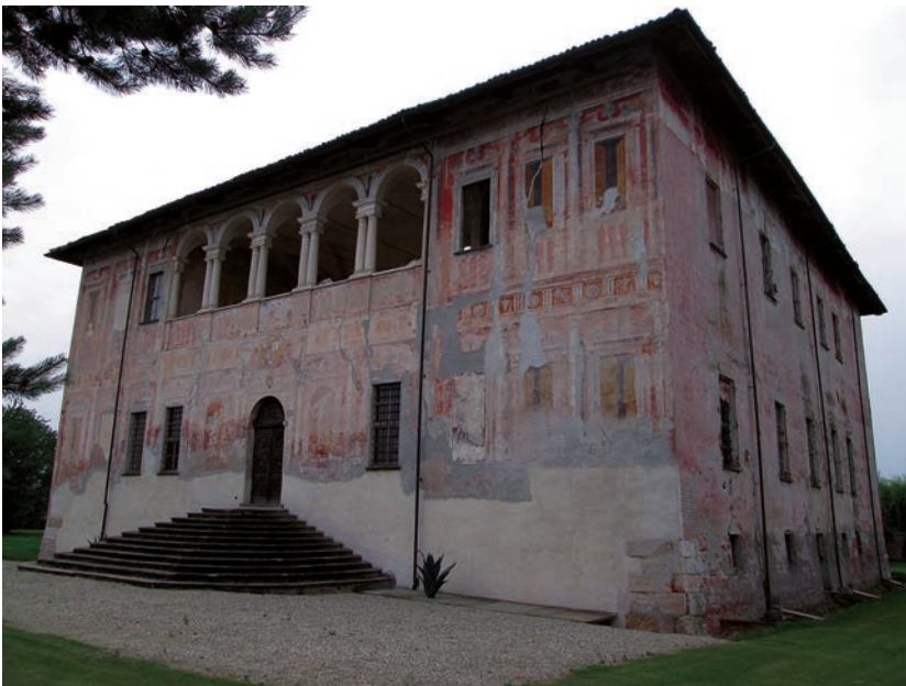
Fig. 5. Villa Maresco. La solidità e la compattezza della costruzione vengono alleggerite unicamente dalla apertura della loggia e dall'apparato decorativo della facciata principale, ripulita dopo l'ultimo restauro (foto L. Blotto, anno 2015).
