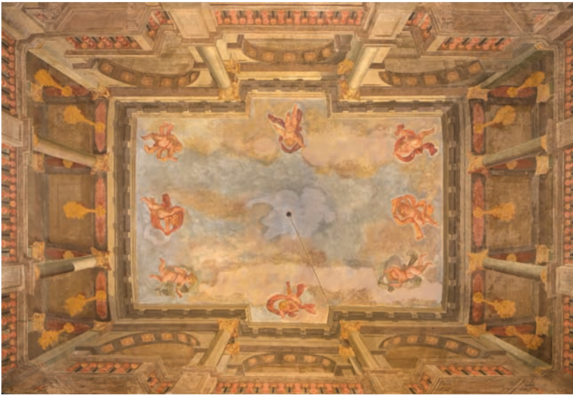
Fig. 6. Ortofoto elaborata con software di dense matching della quadratura di Paolo Pini che mostra la convergenza delle linee prospettiche verso il cervello della volta, marcato dall'anello metallico che sorregge il lampadario.
