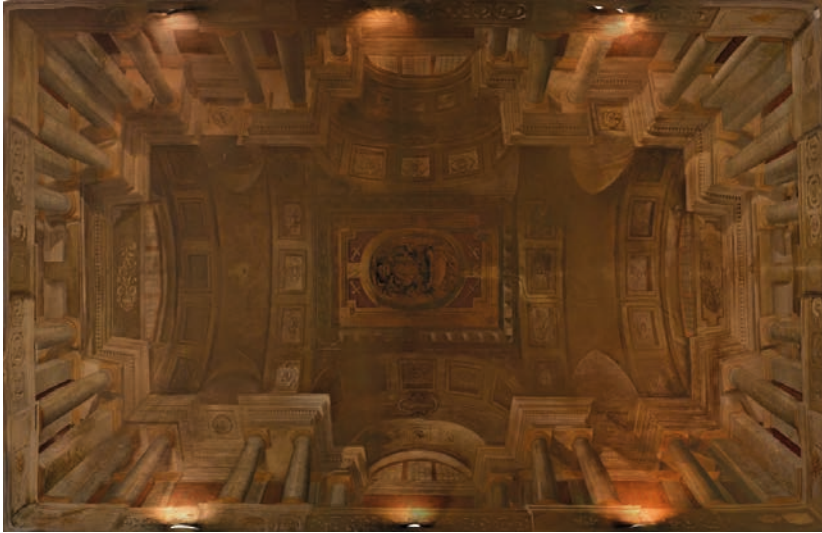
Fig. 3. Volta della Sala del Dentone, Palazzo Comunale di Bologna, Girolamo Curti con Francesco Castelli e Angelo Michele Colonna, 1627-1630 circa. Ortofoto di rilievo elaborata con software di dense matching Agisoft Photoscan.
