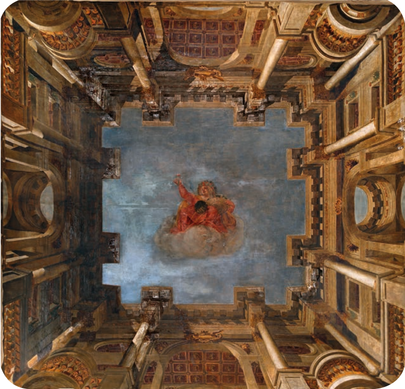
Fig. 4. Ortofoto elaborata con software di dense matching della quadratura di Francesco Castelli (1615-1692) situata al piano terra che richiama lo stile bolognese con la prospettiva a un unico punto, a cannocchiale prospettico, l'uso delle serliane nelle parti centrale, soffitti a lacunari e soluzioni d'angolo con balconate semicirculari negli angoli. Al centro si trova l'unica parte figurativa con l'Allegoria della Munificenza che non va a interferire con la matrice architettonica.
