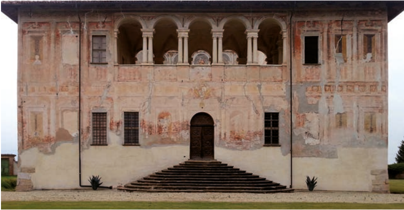
Fig. 6. Fotogramma facciata principale. Raddrizzamento geometrico (D. Miron, anno 2015).
