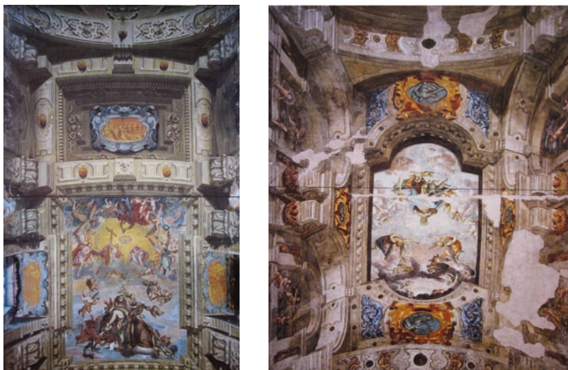
Figg. 2, 3. Particolari del soffitto voltato in Santa Maria del Carmine a Brescia.
