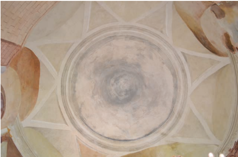
Fig. 7. Vista della cupola.
