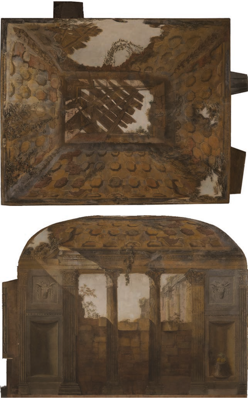
Fig. 10. Ortofoto della volta a padiglione e di una parete della stanza.
