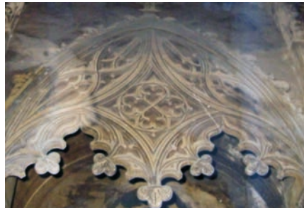
Fig. 22. Chiesa di San Bartolomeo, altare di Santa Caterina, particolare dell'arco. E' qui evidente il motivo ad intreccio paragonabile agli esempi voltati citati. (da A. Marotta, (a cura di), San Bartolomeo in Valenza: rilievi e indagini per il restauro , catalogo della mostra, Centro comunale di cultura, Gruppo femminile del club Turati, Valenza 1991, p. 22).
