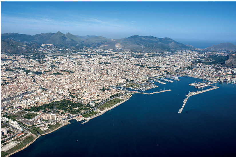
Fig. 1.2. Veduta aerea della città di Palermo dal mare. Si distingue bene la cerchia di monti che circondano la città, tra i quali spicca Monte Cuccio (1050 m. s.l.m.) con la sua doppia cima. L'espansione urbana iniziata nella seconda metà del XIX secolo e che ha avuto un forte impulso negli anni del dopoguerra fino alle soglie del XXI secolo, ha dato luogo alla quasi totale urbanizzazione della Conca d'Oro. Lungo la costa, procedendo da sinistra verso destra, si distinguono: la foce del Fiume Oreto, il porticciolo di S. Erasmo, la Cala e il grande porto con i Cantieri Navali e sullo sfondo, parzialmente, Monte Pellegrino e Monte Gallo. Foto Luigi Nifosi.
