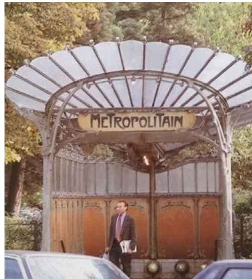
Fig. 5. Progreso Station Access, now Tirso de Molina Station, 1921. Archivo de Metro de Madrid (metromadrid_2770).
