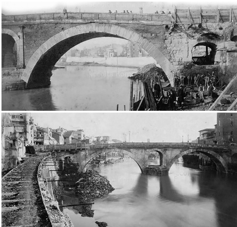
Fig. 5. Spalla sinistra del Ponte Fabricio in cui è visibile il fornice arcuato, 1885-1886 (in alto); Ponte Fabricio a monte durante la costruzione dei muraglioni e dei lungotevere (in basso) (da D'ONOFRIO 1980, pp. 102-103).
