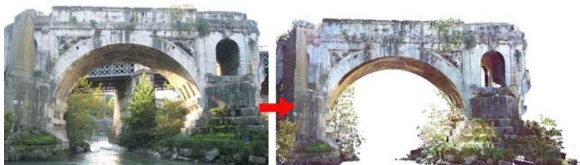
Fig. 6. Fotografia del Ponte Emilio sulla sinistra e nuvola di punti in prospettiva sulla destra, si noti l'elevata risoluzione che quest'ultima mostra (elaborazione di Giulia Umana).
