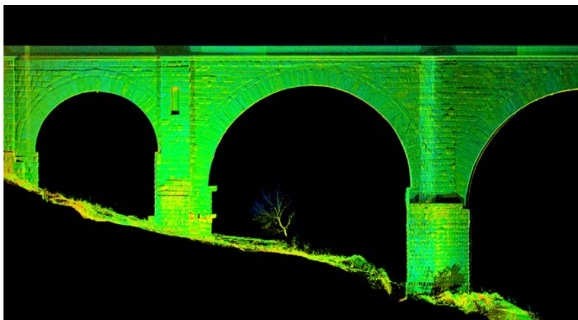
Fig. 8. Ponte di Alcántara. Modello numerico, nuvola di punti con valori di riflettanza. Particolare prospetto nord-est (elaborazione di Carlo Inglese).
