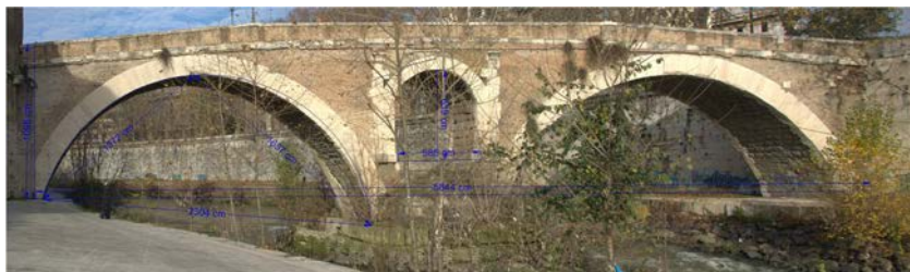
Fig. 11. Prospetto attuale a valle. Fotoraddrizzamento e misurazione delle superfici rettificate (elaborazione di Daniele Maiorino).
