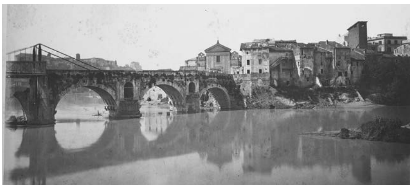
Fig. 12. Il Ponte Emilio nel 1878 con le prime due arcate, demolite pochi anni dopo, e il ponte in ferro di Lanciani, in seguito rimosso con l'apertura del vicino Ponte Palatino (immagine tratta dall'Album XXI S.P.Q.R. Il Tevere. Tronco Urbano. Stato anteriore ai lavori di difesa. Sponda destra. Vedute del Tevere in Roma prima della sua sistemazione". Su concessione dell'Archivio Storico Capitolino, Roma).
