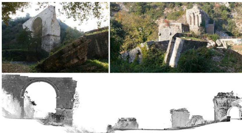
Fig. 5. In alto: viste delle rovine del ponte dalle due sponde del Nera. In basso: registrazione delle macronuvole: la prima arcata da un lato del fiume, le restanti strutture dall'altro (elaborazione di Maria Laura Rossi).
