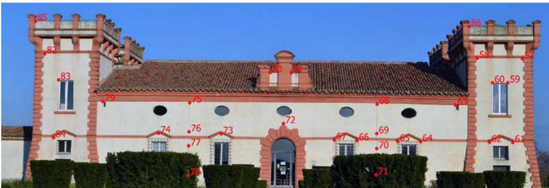
Fig. 5.21. In alto lo schema della rete topografica con la presenza delle stazioni (in giallo), dei PFA a terra segnalati dai target (numerati) o dalla rete fognaria dei tombini (numerati e preceduti dalla lettera T) e dal cono di acquisizione (in rosso) del rilievo delle facciate, in basso la facciata Ovest con evidenziati i PFA sulla facciata.
