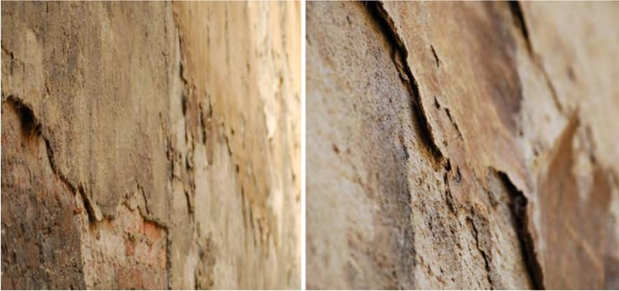
Fig. 5.33. Fotografie di dettaglio della stratigrafia dell'intonaco: si distinguono gli strati di composizione (muratura, arriccio, intonaco) e il loro imminente distacco dalla parete.
