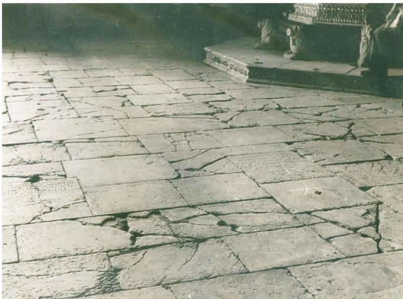
**Fig. 14.** Duomo di Orvieto, navata centrale. L'ammalorato pavimento originario prima dell'intervento sostitutivo del 1954.
