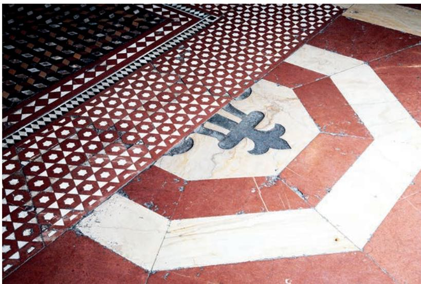
Fig. 18. Duomo di Orvieto, dettaglio dell'inserimento del nuovo pavimento che interrompe brutalmente il farnesiano pavimento gigliato nella parte più prossima al presbiterio.
