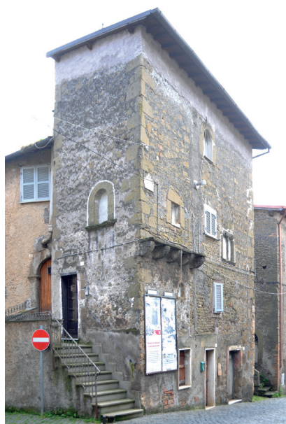
Fig. 2. Foto della facciata in via del Borgo (2021).
