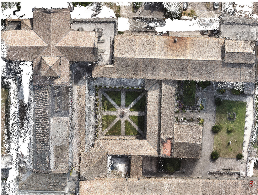
Fig. 1. A. Nuvola di punti realizzata da scanner laser del complesso di Fossanova. B. Nuvola di punti realizzata da drone del complesso di Casamari (elaborazione grafica degli autori).
