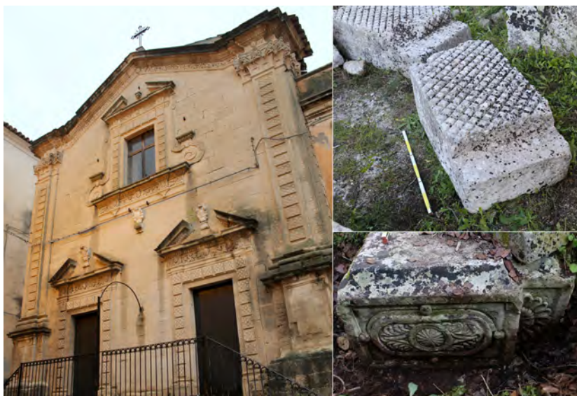
Fig. 6. Militello Val di Catania, chiesa della Catena, a sinistra (foto di A. Antista). Noto antica, conci decorati con bugnato a graticcio (destra in alto) e concio di base del portale della chiesa provvisoria (destra in basso) (foto dell'autrice).
