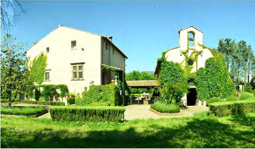
Fig. 4. Prospetto est della residenza e della chiesa (foto dell'autrice).
