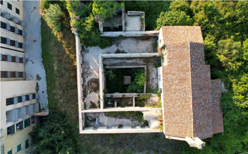
Fig. 10. Chiostro di Santissima Maria di Costantinopoli (foto dell'autore).
