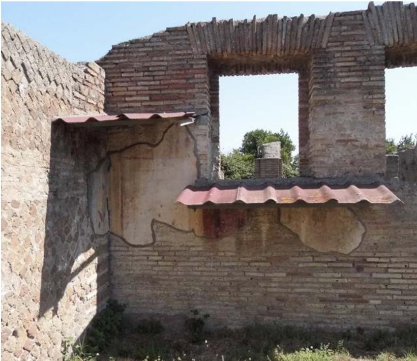
**Fig. 3.** Alterazione cromatica della tinta legata al soleggiamento e alla cattiva progettazione dei sistemi di protezione (foto dell'autrice).
