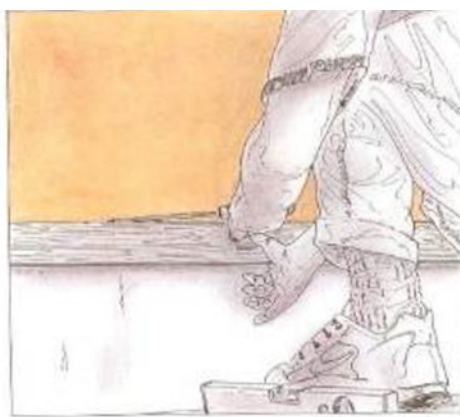
38. Trazado de la junta con punzón.
