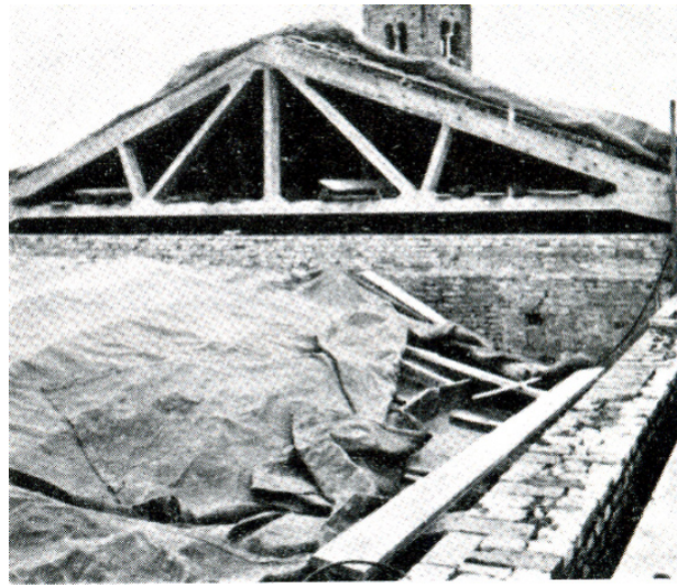
Fig. 31. Basilica of Sant' Apollinare Nuovo, Ravenna. From G. Carbonara (a cura di), Restauro e cemento in Architettura , Aitec, Roma 1981, p. 146.
