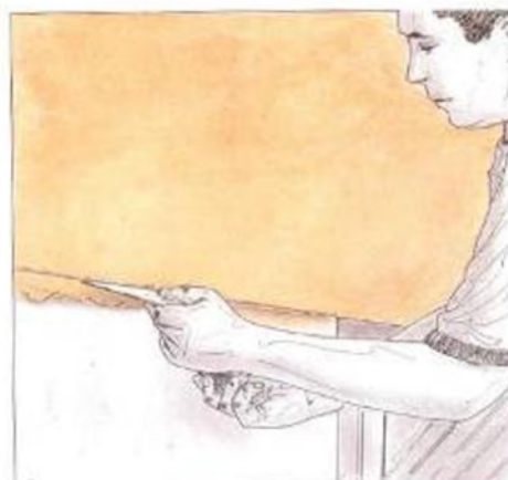
40. Entrazo del material de la junta con el del resto del paramento.
