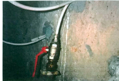
PREDISPOSIZIONE DEI FORI SECONDO LO SCHEMA A QUINCONCE ED INSERIMENTO DEI TUBETTI DI IMMISSIONE MISCELA
