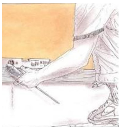
37. Uso de la regla para trazar la junta.
