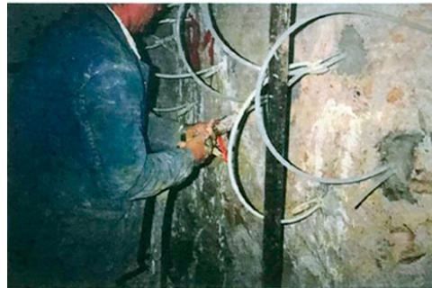
POMPAGGIO DELLA MISCELA ALL'INTERNO DELLA MURATURA ATTRAVERSO GLI APPOSITI TUBETTI
