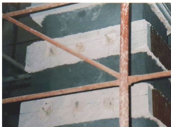
Fig. 59. Cathedral of Palestrina, Rome. From F. Marmo, Materiali fibro-rinforzanti a matrice polimerica , "Materiali e strutture", Anno 2, n. 34.
