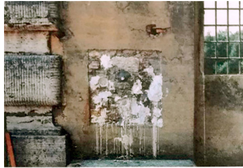
PREPARAZIONE DELL'AREA SULLA QUALE CONDURRE LA PROVA ED EVENTUALE ASPORTAZIONE DELL'INTONACO
