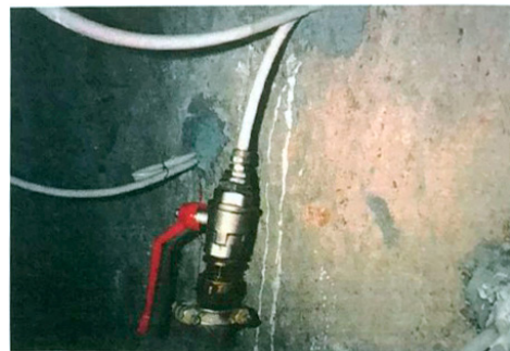
PREDISPOSIZIONE DEI FORI SECONDO LO SCHEMA A QUINCONCE ED INSERIMENTO DEI TUBETTI DI IMMISSIONE MISCELA
