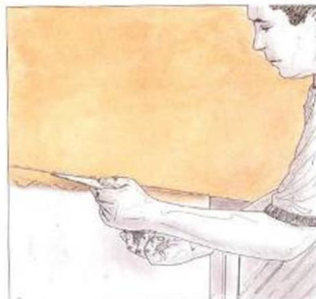
40. Entaso del material de la junta con el resto del paramento.
