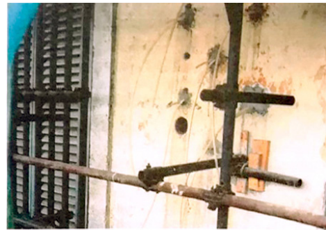
PREDISPOSIZIONE DEI FORI SECONDO LO SCHEMA A QUINCONCE ED INSERIMENTO DEI TUBETTI DI IMMISSIONE MISCELA
