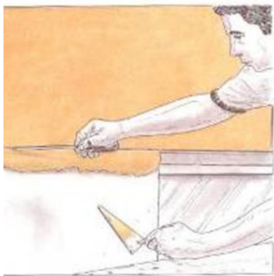
39. Trazado de la junta con punzón.
