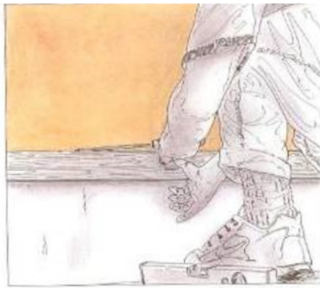
38. Trazado de la junta con punzón.
