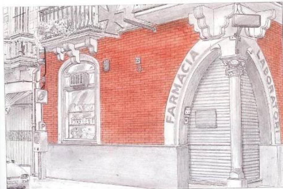
6. Vista de la fachada terminada con estuco enfucido imitación de ladrillo.
