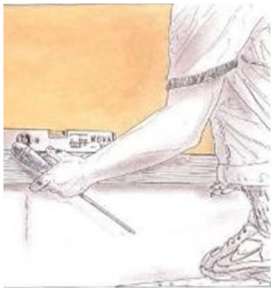
37. Trazado de la junta con la regla para trazar la junta.
