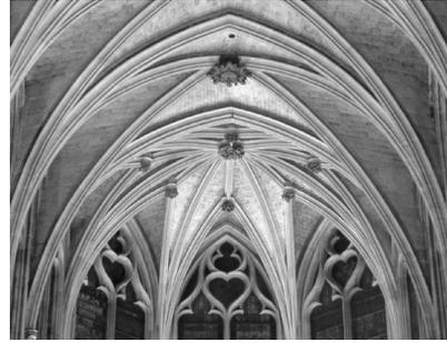
Fig. 1.24. Dettaglio della volta e delle sue chiavi nella chiesa di Saint-Séverin (Parigi).
