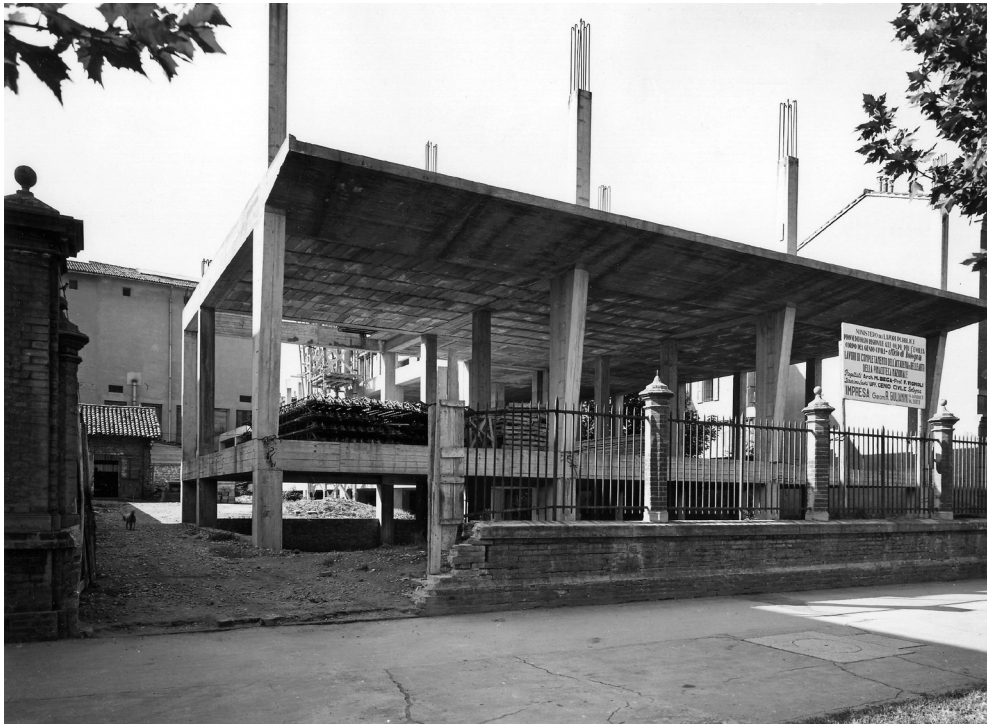
Fig. 2. Costruzione della nuova ala di ponente della Pinacoteca nazionale di Bologna (1956), Foto Zagnoli, Bologna, Archivio fotografico della Direzione regionale musei, inv. GF001330, su concessione del Ministero della Cultura - Direzione regionale musei dell'Emilia-Romagna.
