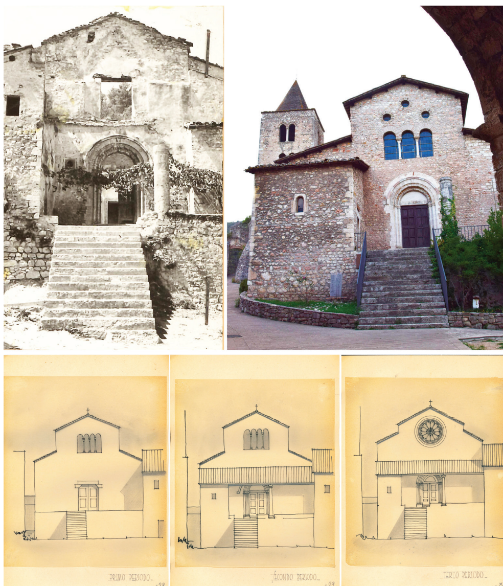
Fig. 4. Abbazia di S. Cassiano a Narni, foto della facciata della chiesa ed elaborati delle “pezze d’appoggio” (ADF- DSDRA, PDA cart. 12 fasc. 5, parte tav. 5 e tavv. 28-29-30, studente Franco Maroni) e foto dello stato di fatto (foto dell’a. 2023).
