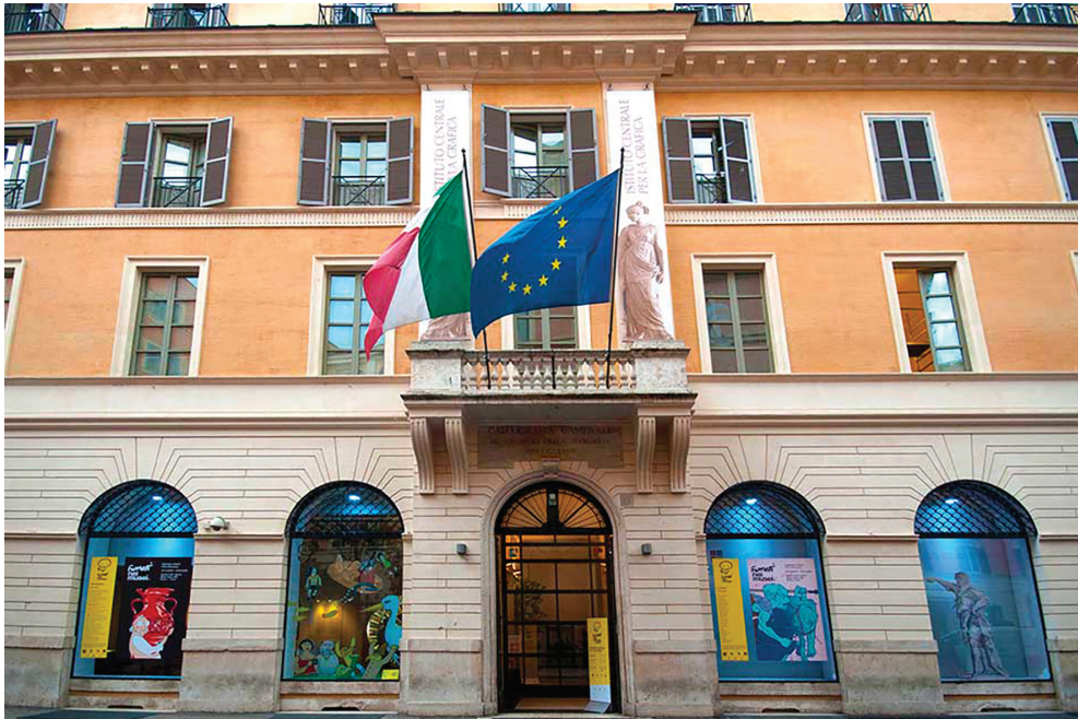
Fig. 1. Facciata dell'Istituto Centrale per la Grafica, ingresso via della Stamperia, 6.
