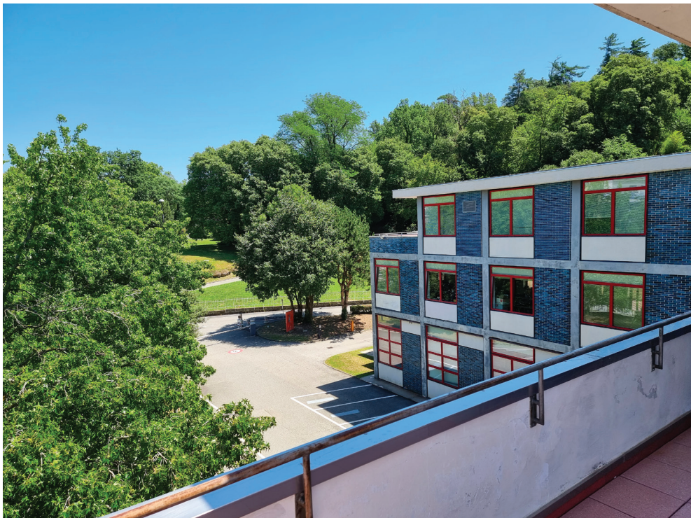
Fig. 4. "Casa Blu Olivetti", Eduardo Vittoria 1951-1954. Attuali headquarters eporediesi di Olivetti Spa, nacque come Centro Studi ed Esperienze dell'azienda: un edificio dedicato alla tecnologia di frontiera, vero e proprio hub dell'innovazione tecnologica olivettiana. Contraddistinta dalle mattonelle blu del rivestimento esterno, fu anche la sede dell'Interaction Design Institute (2001-2005).
