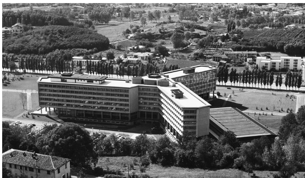
Fig. 5. Il "Centro dei Servizi Sociali", Luigi Figini e Gino Pollini 1954-1959 con Roberto Guiducci, Paolo Radogna. Parallelo alle Officine ICO di Via Jervis, è composto da due corpi di fabbrica raccordati da uno verticale autonomo e da una pianta esagonale, leggibile anche nella struttura a vista dell'edificio che si sviluppa su tre piani, tra loro sfalsati. Fototeca dell'Associazione Archivio Storico Olivetti.
