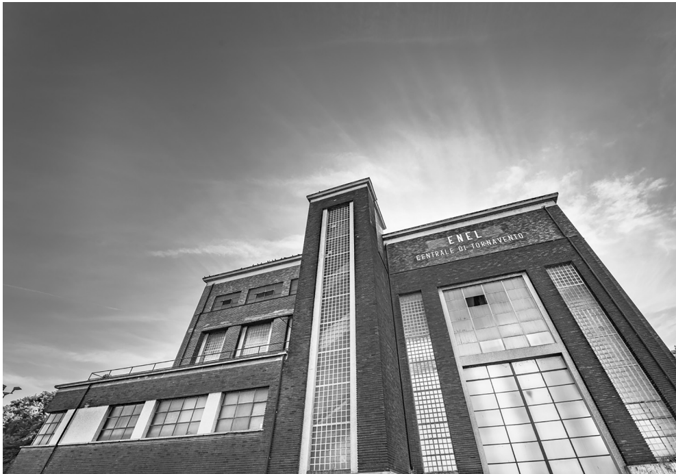
Fig. 5. Centrale di Tornavento, Ticino (Archivio Storico ENEL, Napoli).
