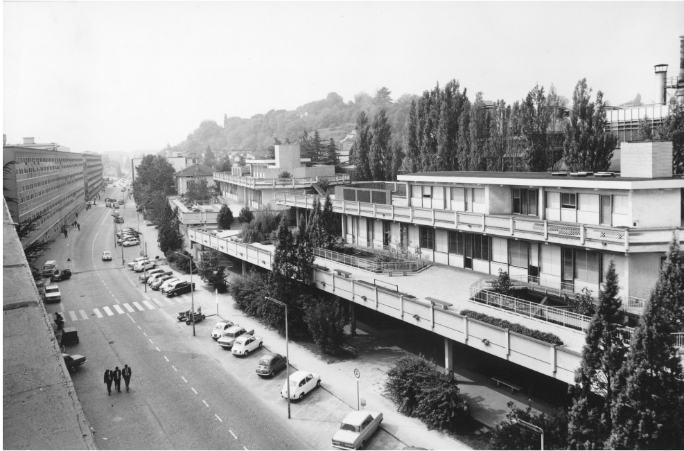
Fig. 3. Il "Centro dei Servizi Sociali", Luigi Figini e Gino Pollini 1954-59 con Roberto Guiducci, Paolo Radogna. Parallelo alle Officine ICO di via Jervis, è composto da due corpi di fabbrica raccordati da uno verticale autonomo e da una pianta esagonale, leggibile anche nella struttura a vista dell'edificio che si sviluppa su tre piani, tra loro sfalsati. Fototeca dell'Associazione Archivio Storico Olivetti.
