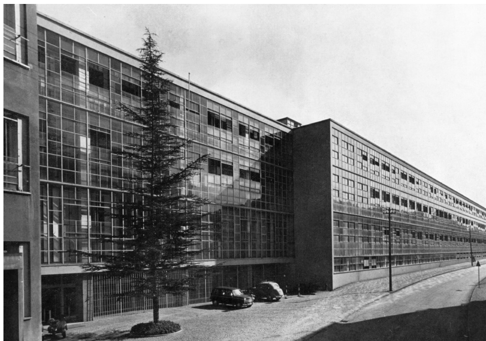
Fig. 2. "Officine ICO", lo sviluppo orizzontale della prima fabbrica Olivetti. Realizzati a partire dal 1934 su progetto degli architetti Luigi Figini e Gino Pollini, scelti da Adriano Olivetti per l'incarico, i quattro ampliamenti seguono la "Mattoni Rossi" e si estendono in via Jervis. Fototeca dell'Associazione Archivio Storico Olivetti.
