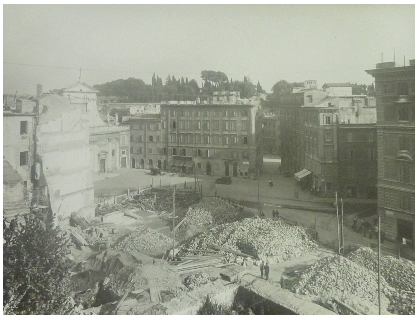
Fig. 70. I lavori in corso nell'area di piazza della Consolazione. Non è stato ancora effettuato l'abbassamento stradale. (AV, Scatola 25).
