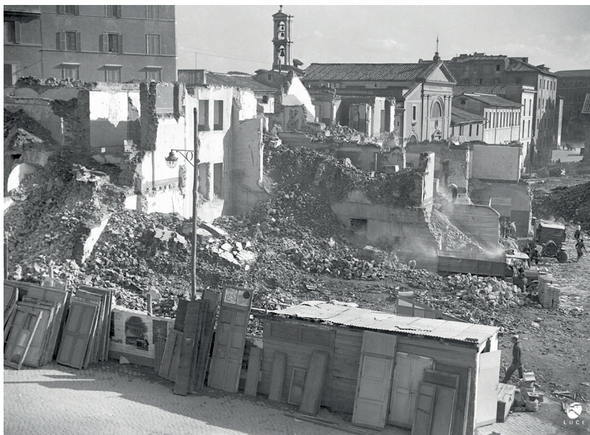
Fig. 60. Avanzamento dei lavori di demolizione nell'area antistante Piazza della Consolazione. Sullo sfondo a sinistra dell'immagine si vede la chiesa di Sant'Omobono. (AL, A00067172).
