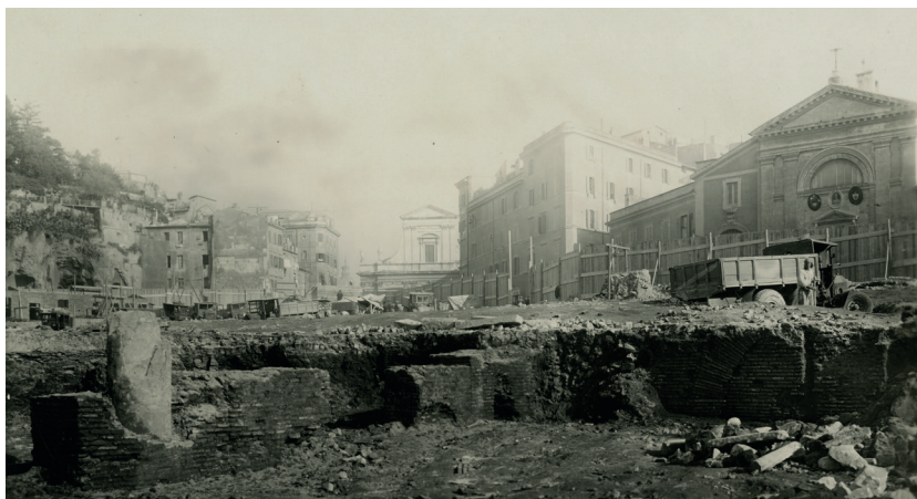
Fig. 78. A destra si osserva la facciata della chiesa di Sant'Omobono durante l'abbassamento del livello stradale di via della Consolazione. (MR, AF 34252, Roma Capitale, Sovrintendenza Capitolina ai Beni Culturali).
