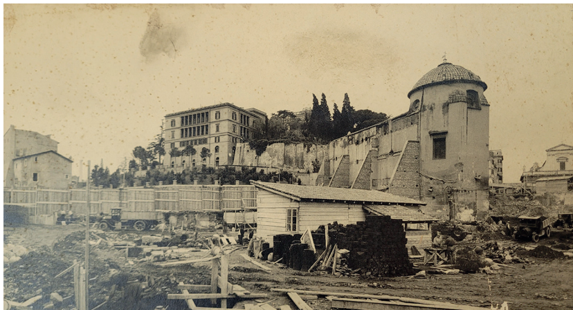
Fig. 77. Il retro della chiesa di Sant'Omobono durante la demolizione dell'isolato. (AV, Valle. Pro/69, Cartella 10).
