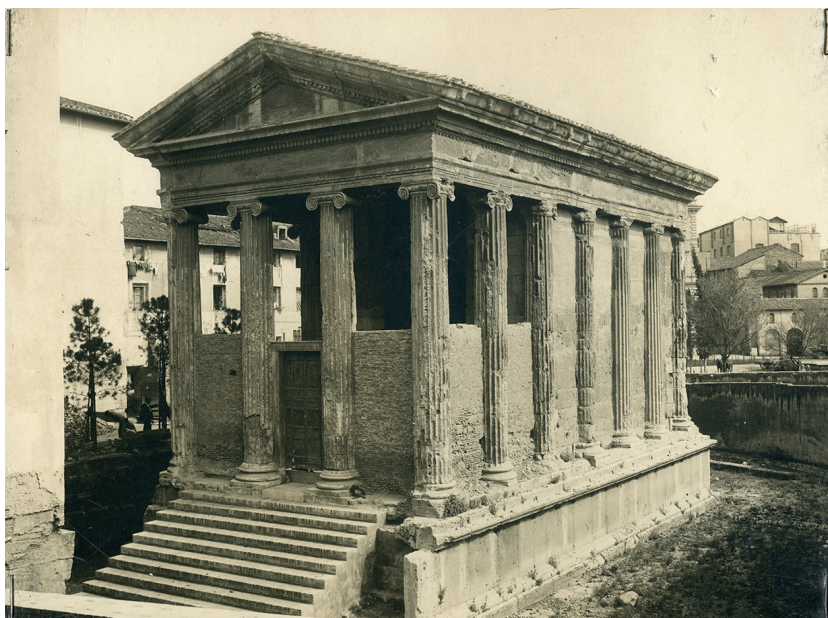
Fig. 44. Fotografia del fronte del Tempio della Fortuna Virile dopo il suo isolamento in un momento precedente agli interventi urbanistici della piazza adiacente. (ICCD, Gabinetto Fotografico Nazionale, E8300).
