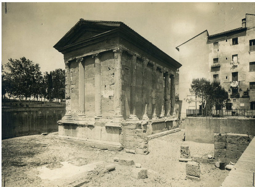
Fig. 43. Fotografia del retro del Tempio della Fortuna Virile dopo il suo isolamento in un momento precedente agli interventi urbanistici della piazza adiacente. (ICCD, Gabinetto Fotografico Nazionale, E8299).
