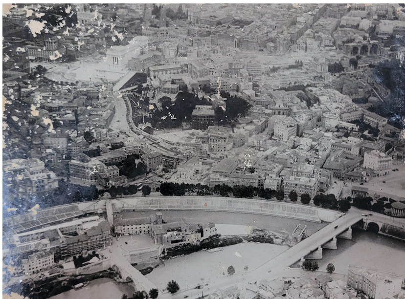
Fig. 17. Vista a volo d'uccello dell'area di studio durante la costruzione del primo tratto della via del Mare e con la piazza della Bocca della Verità già ultimata. (AV, Pro/69, Cartella 10).
