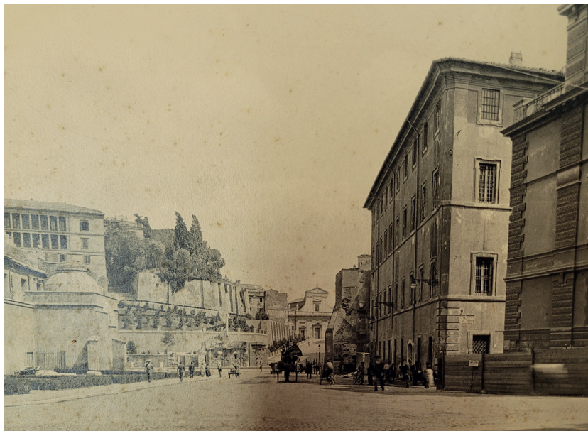
Fig. 62. Fotografia della via della Consolazione – in salita - dopo la prima parte della sistemazione. (AV, Pro/69, Cartella 10).
