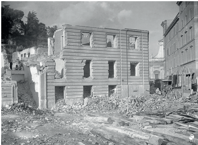
Fig. 59. Avanzamento dei lavori di demolizione nell'area antistante Piazza della Consolazione. In fondo alla via si vede la chiesa di Santa Maria della Consolazione. (AL, A00067168).
