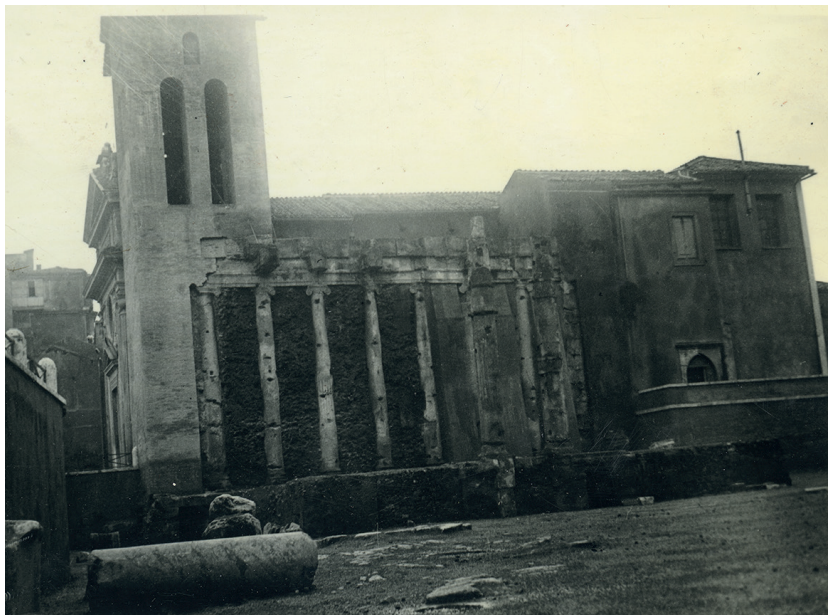
Fig. 30. San Nicola in Carcere dopo l'intervento, con la sua torre ricostruita. (ICCD, Gabinetto Fotografico Nazionale, M5773).
