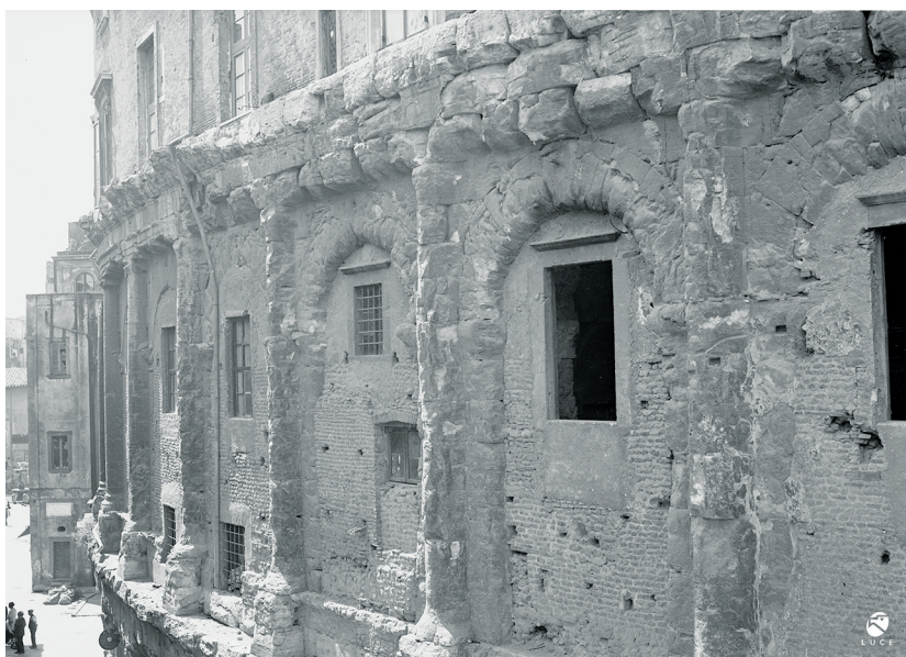
Fig. 24. Particolare della facciata del Teatro di Marcello prima del progetto di isolamento e restauro. (AL, L00006313).
