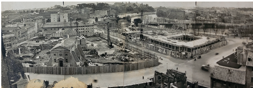
Fig. 64. Lavori di demolizione e ricostruzione nell'area oggetto di studio. Si osservano i setti di rinforzo a Sant'Omobono e gli edifici progettati da Valle e Guidi per gli Uffici delle Ripartizioni III, IV e V del Governatorato in fase di costruzione. (AV, Pro/69, Cartella 10).
