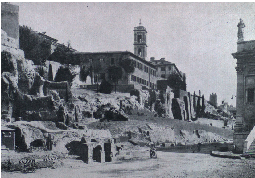
Fig. 67. I lavori in corso nell'area di piazza della Consolazione. (MUÑOZ 1943, TAV. XLIII).
