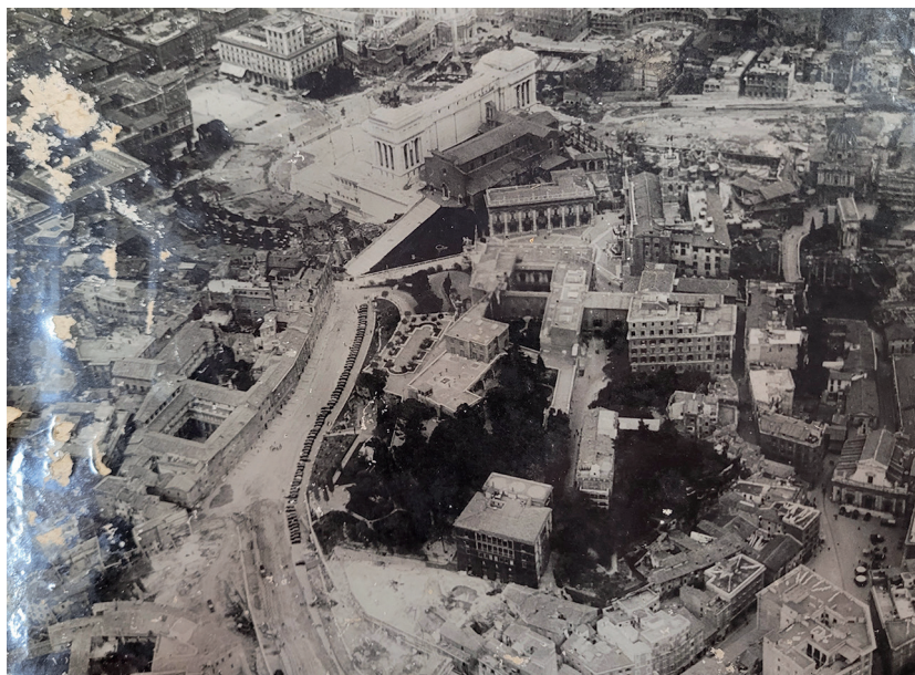
Fig. 18. Vista dall'alto del cantiere della via del Mare. (AV, Pro/69, Cartella 10).
