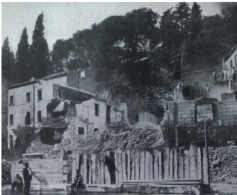
Fig. 66. I lavori in corso nell'area di piazza della Consolazione. (MUÑOZ 1943, TAV. XXXI, sopra).
