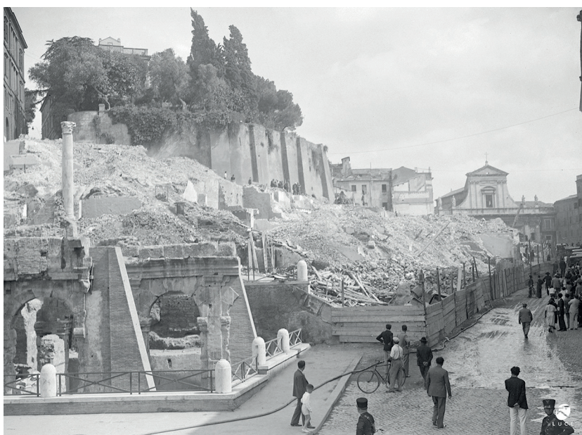
Fig. 58. Lo stesso angolo ma dopo le demolizioni. (AL, A00050029).
