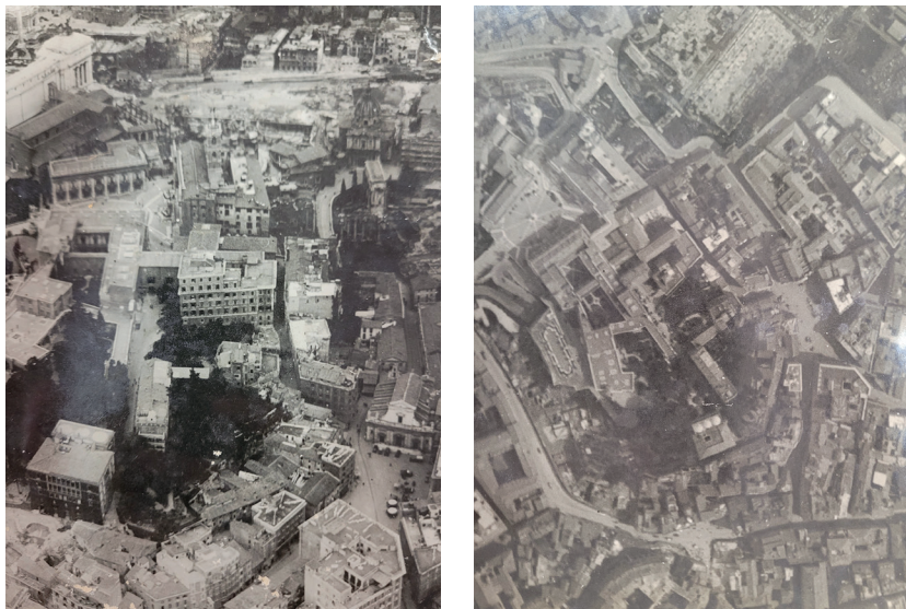
Figg. 51 e 52. Foto aeree che mostrano il tessuto urbano prima delle demolizioni nella zona. (AV, Pro/69, Cartella 10).
