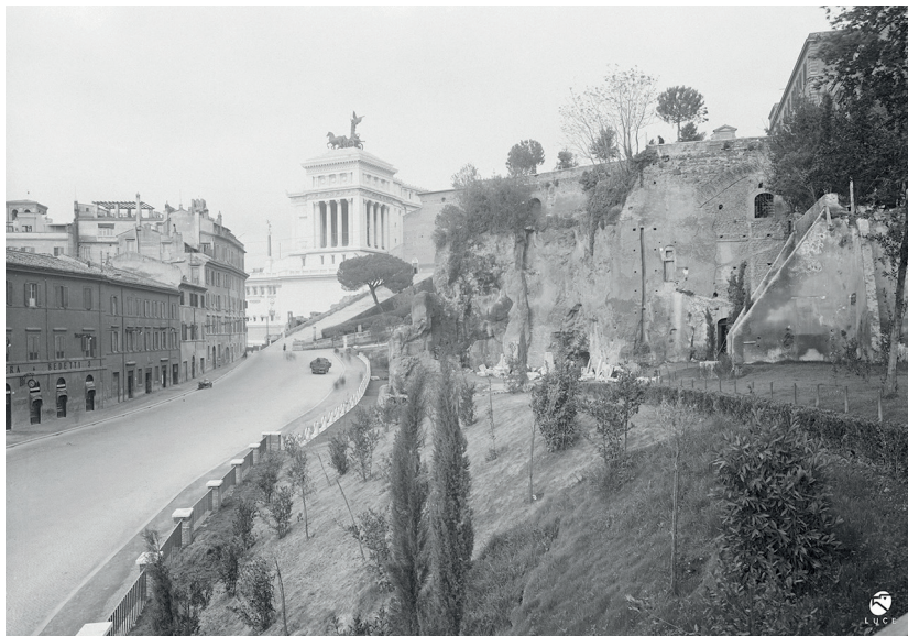
Fig. 33. I lavori su via del Mare e la prima parte dei lavori di isolamento del Campidoglio appena terminati. Da notare la vegetazione appena piantata sulle pendici della collina. (AL, L00006876)
