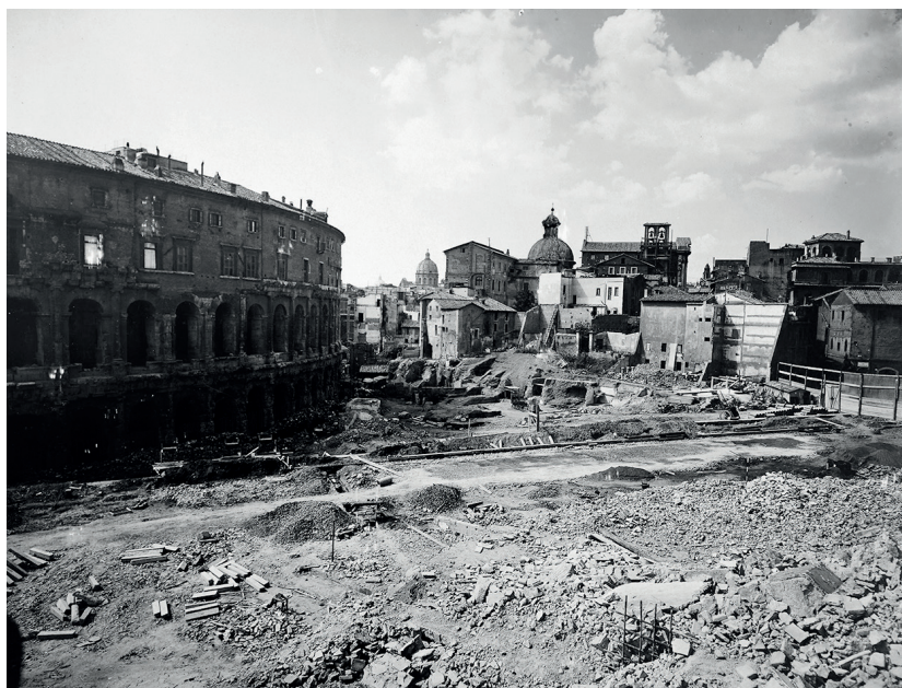
Fig. 26. Lavori in corso per l'apertura della Via del Mare e l'isolamento del Campidoglio. (MR, AF 27065, Roma Capitale, Sovrintendenza Capitolina ai Beni Culturali).
