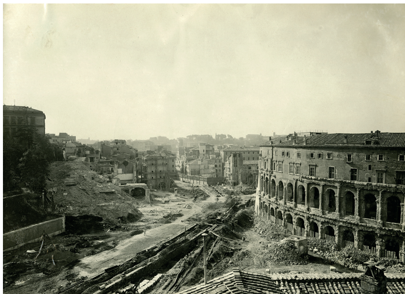
Fig. 25. Lavori in corso per l'apertura della Via del Mare e l'isolamento del Campidoglio. (MR, AF 27064, Roma Capitale, Sovrintendenza Capitolina ai Beni Culturali).
