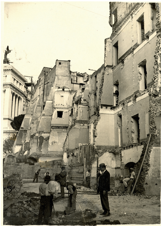
Fig. 32. Lavori di demolizioni nelle pendici del Campidoglio, 1928 (circa). (MR, AF 5513, Roma Capitale, Sovrintendenza Capitolina ai Beni Culturali).
