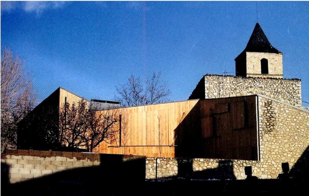
Fig. 33 - House in Lles de Cerdanya. (SM 2018)
