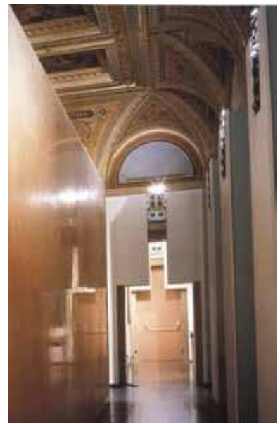
Fig. 6 - Venezia, Palazzo Grassi, partition wall. (CB 1985)
