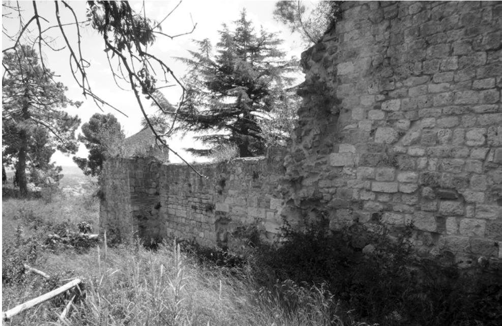
Fig. 2.18. L'interno della Fortezza Pia verso la parete sud. Si notano tracce dell'ammorsatura muraria di una precedente costruzione nel punto di discontinuità della cortina (fotografia di Andrea Bruschi).
