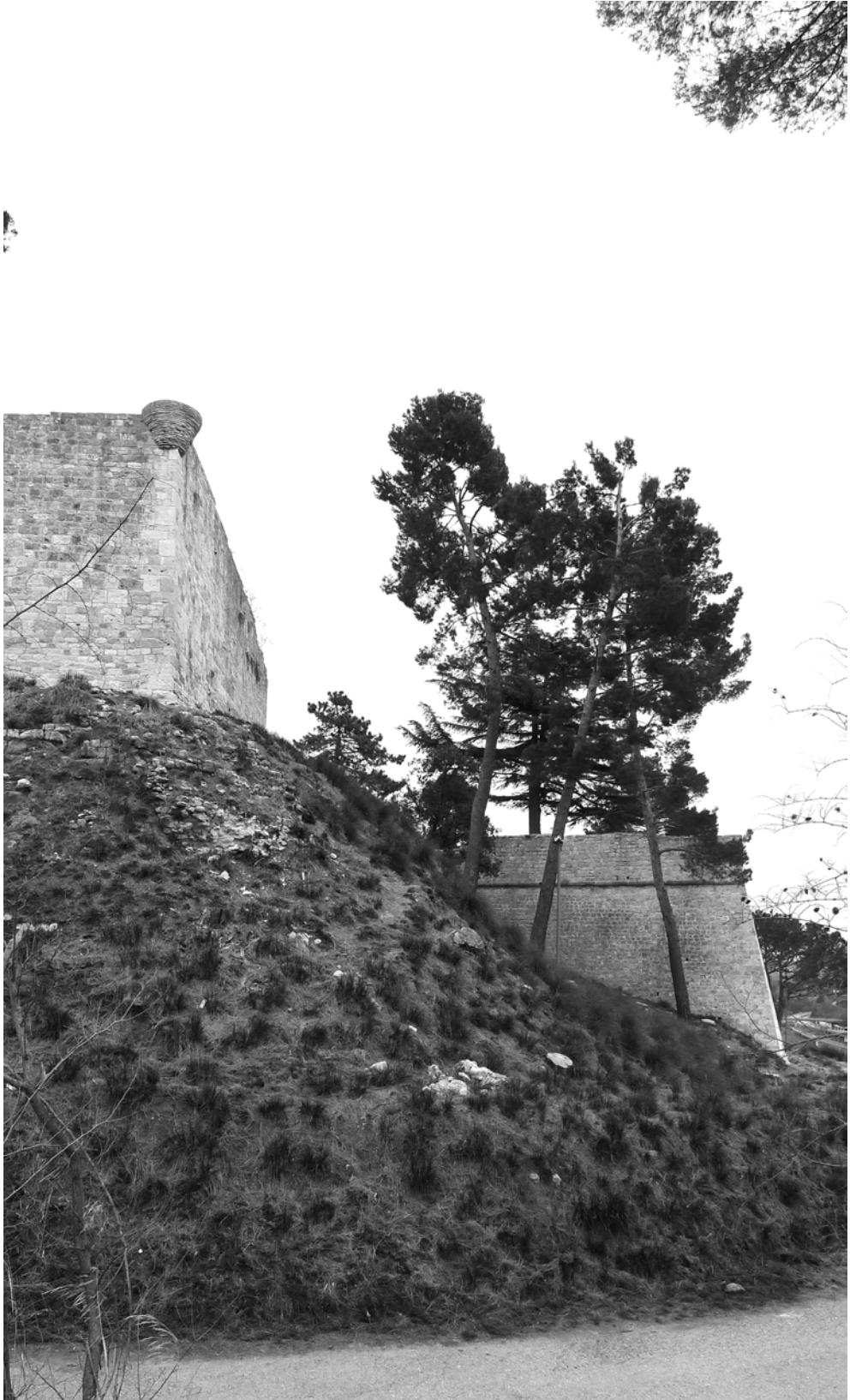
Fig. 2.8. Scorcio del fronte sud, a sinistra l'angolo fra le cortine ovest e sud, a destra il bastione meridionale (fotografia di Pier Filippo Melchiorre).
