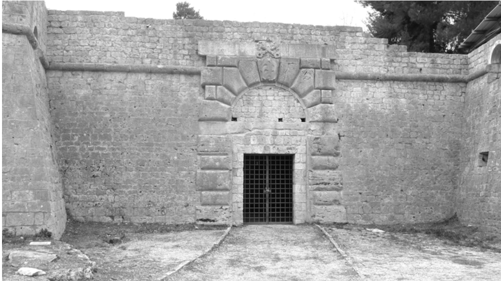
Fig. 3.3. Il portale di ingresso protetto dai fianchi dei bastioni del fronte est (fotografia di Andrea Bruschi).
