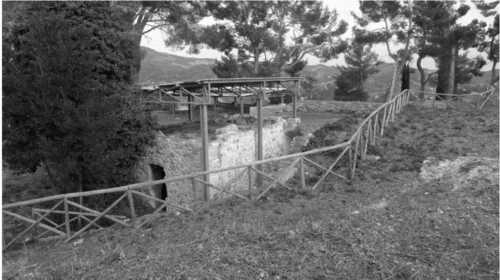
Fig. 4.5. La laconica tettoia in acciaio realizzata nel 1994 a protezione dei ruderi della Casa del castellano (fotografia di Andrea Bruschi).
